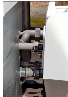
Die Verrohrung ist ab Werk schon passend vorbereitet, so dass sie werkzeuglos montiert werden kann
