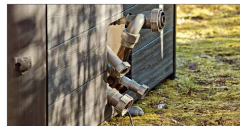
Nach dem Einlegen der Poolwanne werden die Anschlüsse nach außen durchgesteckt
