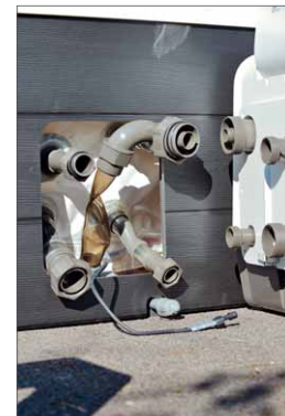
Die Verrohrung ist ab Werk schon passend vorbereitet, so dass sie werkzeuglos montiert werden kann
